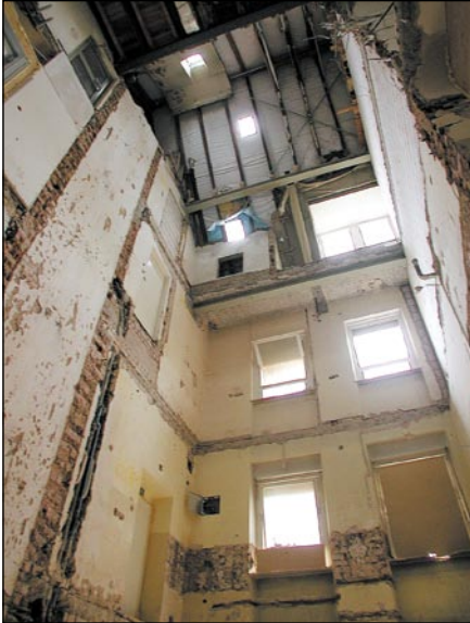
Entkernung des Treppenhauses im nördlichen Teil des Instituts (Dezember 2004) Demolition of the stairwell in the northern part of the institute (December 2004)
