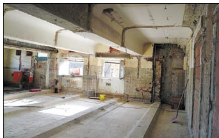
Abrisse des Labortraktes im Zwischengeschoss (Sommer 2008) Demolition of the laboratories in the mezzanine floor (Summer 2008)
